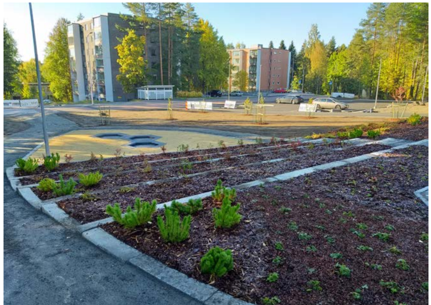
Pupumuorinpuisto viimeistelytöitä tehty.
