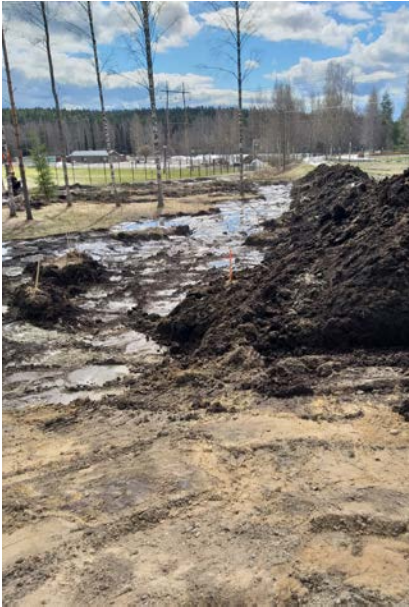
Kangasrinteenpuiston kevytväylän pohja kaivettuna.
