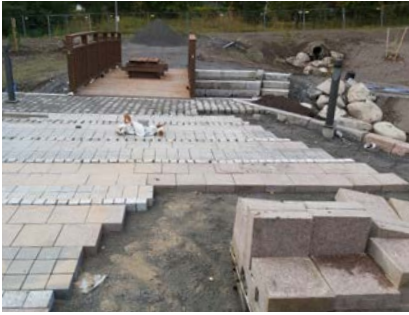
Pielespuiston kiveys rakenteilla.
