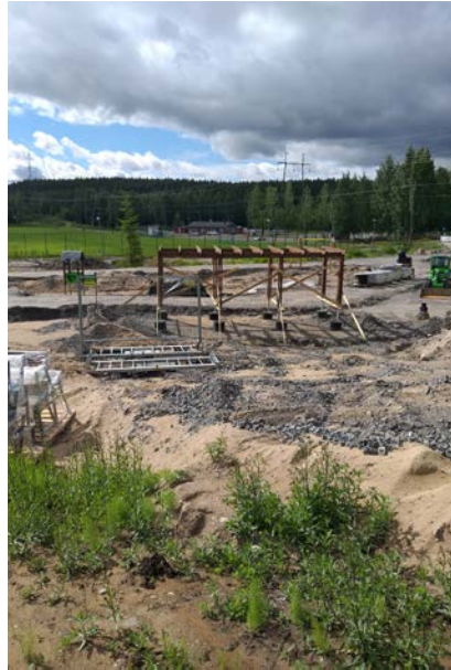
Kangasrinteenpuiston pergola rakenteilla.
