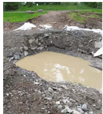
Pielespuiston pato rakenteilla.
