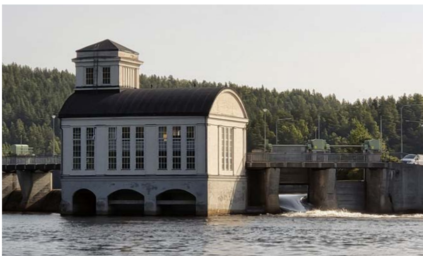
Vaajakosken vanha vesivoimalaitos eli Wanha Woimala. Kuva Timo Mattila
