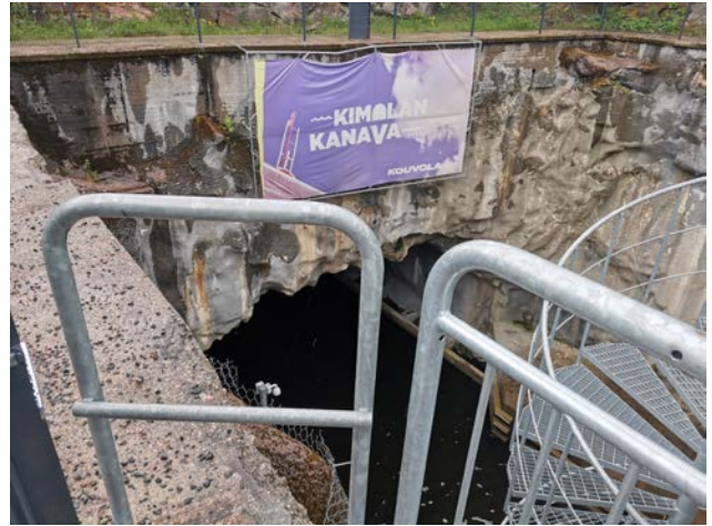
Kimolan kanava kulkee kallion läpi tunnelissa.
